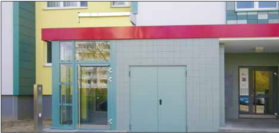
Neugestalteter Hauseingangsbereich in der Fichtelbergstraße 20 mit integriertem Zugang zum Behindertenlift
